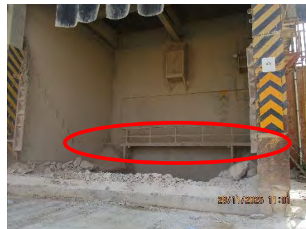
ภาพที่ 2-15 ม่านรูดและระบบสเปรย์น้ำบริเวณโรงโม่
